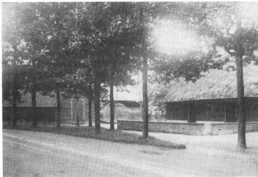
Westgevel gezien vanuit het zuidwesten.
