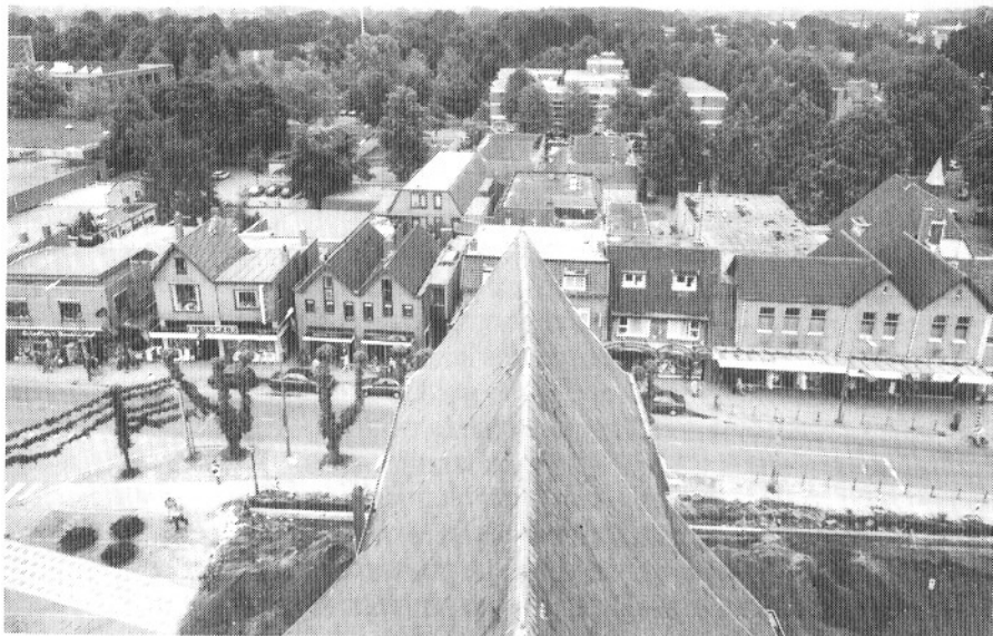
Overzicht over het dak van het schip en het koor. Foto archief RDMZ, A.J. van der Wal, mei 1994
