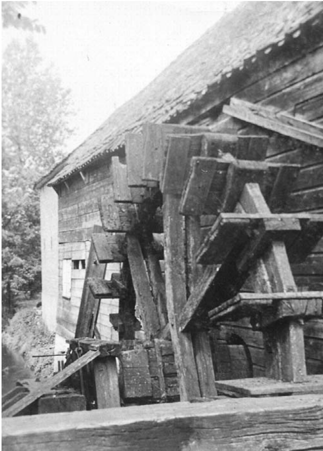
Het onderslagrad van de Grijtse Molen, verwijderd in 1938. Foto: W. Terwel.
