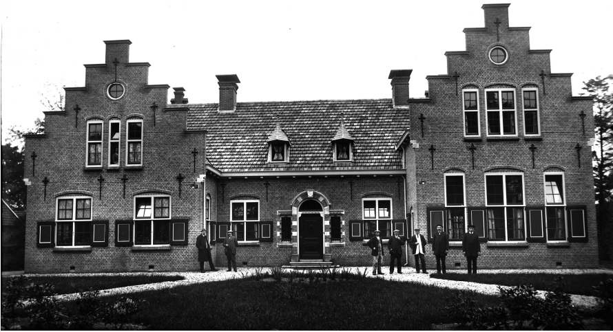
De EGW bij de oplevering, met de architect en de aannemers
