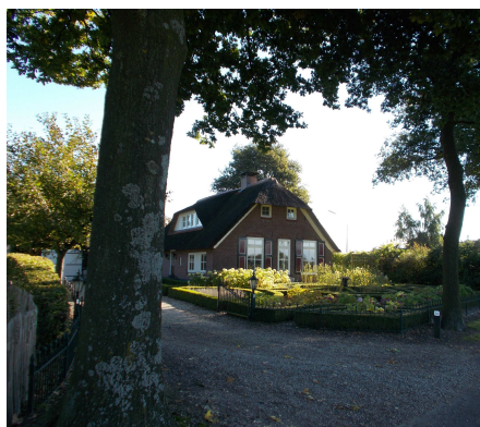
De huidige situatie Hanendorperweg 56 ('Vorselman'). De woning werd begin deze eeuw gerenoveerd.
