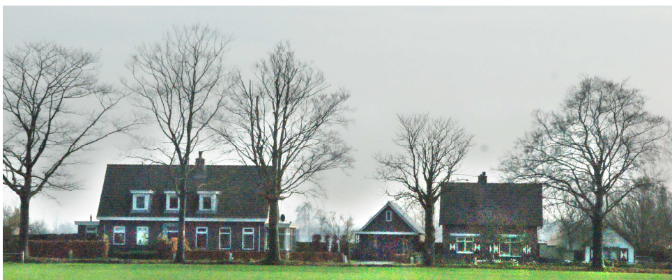
De Esschertbrug (Weteringdijk 45 & 47), 2013
