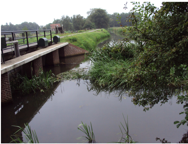
Inlaat van de Grift in het Kanaal
